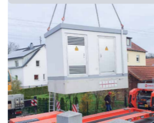
April 2024: Aufstellung Trafostation Sandfeldstraße
