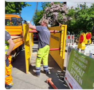
April 2024: Fernwärme Habichtstraße
