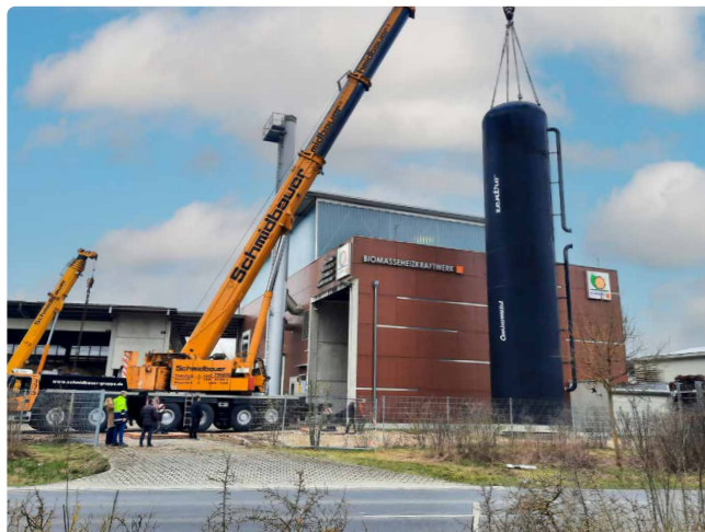
Februar 2024: Aufstellung und Inbetriebnahme Pufferspeicher am Biomasseheizkraftwerk
